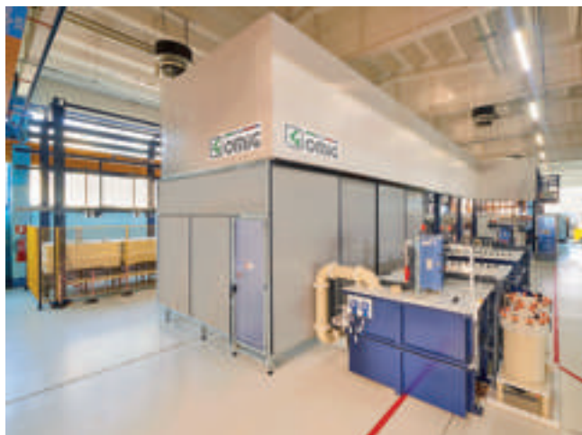
Impianto con copertura a tunnel
