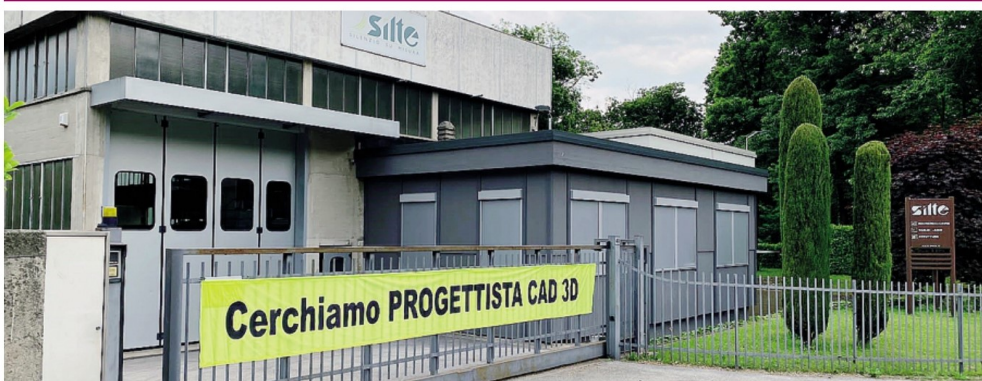
Lo striscione appeso al cancello della Silte che ha sede in Via Bergamo a Galbiate
