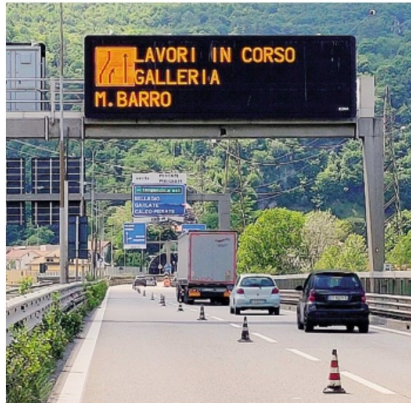
I lavori di lunedì nel tunnel del Barro
