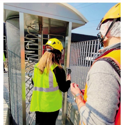
Uno degli ingressi riservati ai lavoratori
