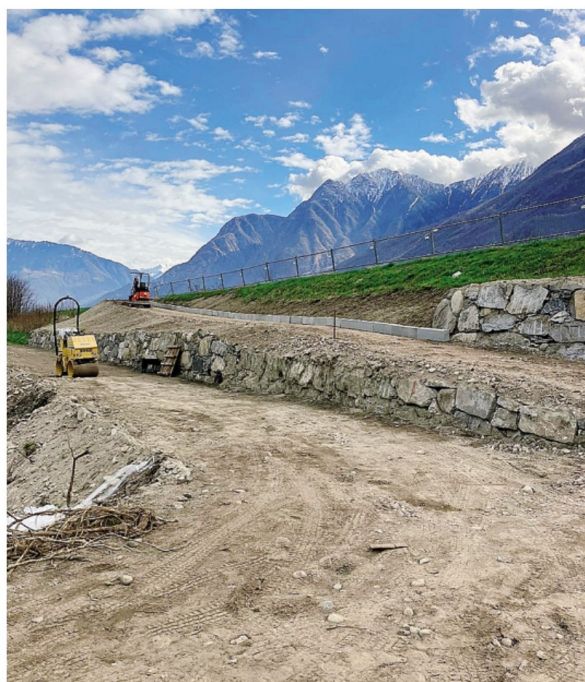
La nuova bretella di collegamento con la pista ciclopedonale a Gordona: lavori ormai a buon punto
