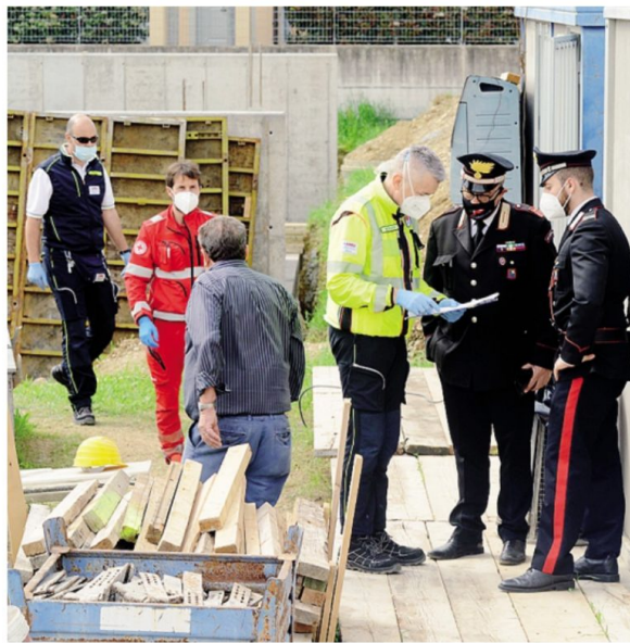
Personale addetto alle verifiche e i carabinieri in un cantiere edile a seguito di un infortunio sul lavoro
