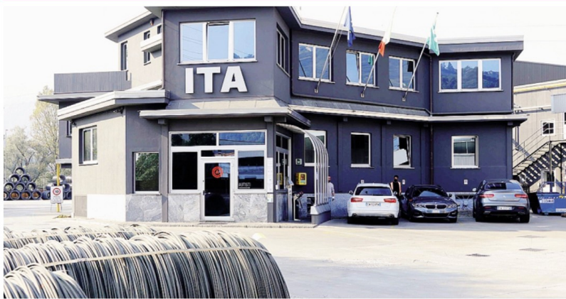
La palazzina degli uffici della sede Ita a Calolzio, l'impresa occupa 120 addetti
