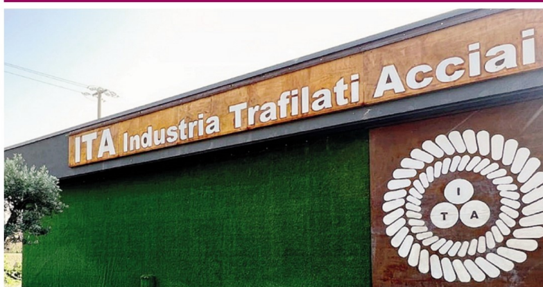
L'esterno dello stabilimento calolziense della Ita
