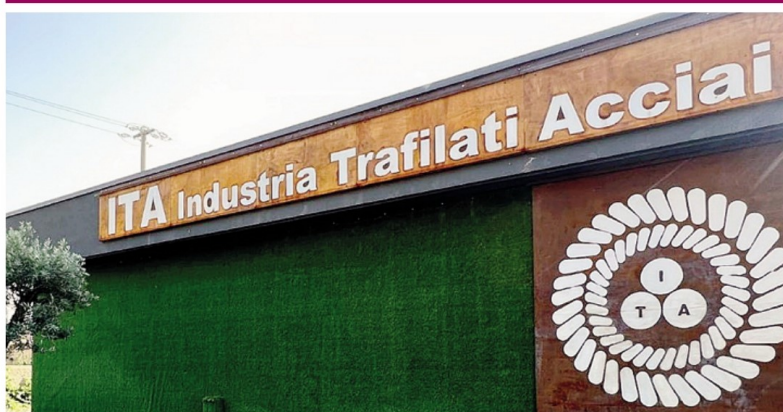
L'esterno dello stabilimento calolziense della Ita
