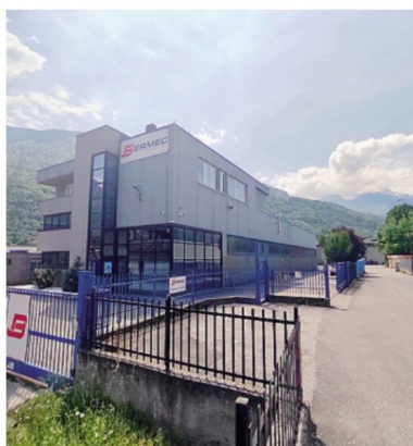
La sede a Talamona della Bermec
