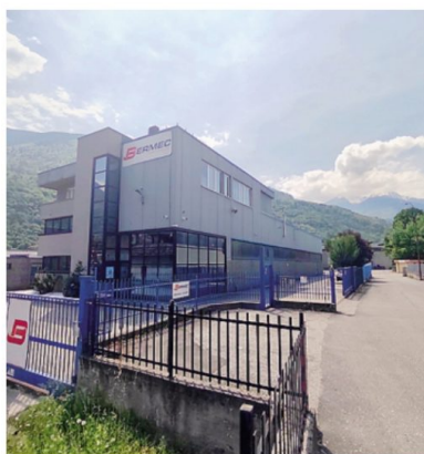
La sede a Talamona della Bermec
